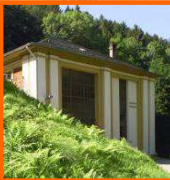
LWKW Bockeloh: installierte Leistung: 1,95 MW Jahreserzeugung: ca. 5,8 GWh
