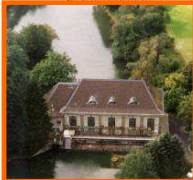
LWKW Wilhelmsthal: installierte Leistung: 1,2 MW Jahreserzeugung: ca. 2,7 GWh
